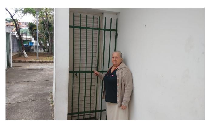
A saída de emergência está obstruída, com cadeados e ferros, não proporcionado aos servidores rota de fuga em caso de incêndio
